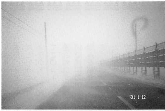
▲ 地吹雪の中の「吹き払い式防雪柵」。高さはメーカーにもよるが3.45m
