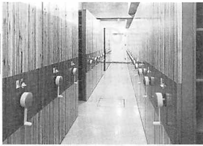
ラックの表面パネルにはスギの間伐材。収納庫内を明るい雰囲気としている
