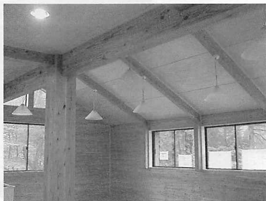
写真④ 梁桁はカラマツ2本合わせ梁（ツインビーム） 中央はカラマツ4本合わせ柱
