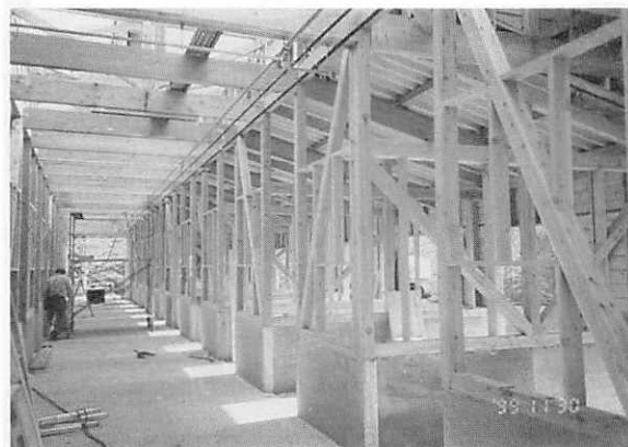
写真③ 構造材すべてがカラマツ高温乾燥材の厩舎
