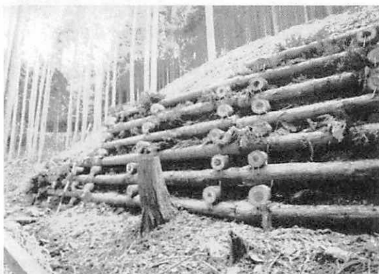
写真① 丸太組路側擁壁工
