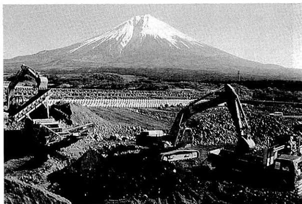
写真③ 第7床国工における除石状況。振り分けて養浜材、道路改良等に利用された
