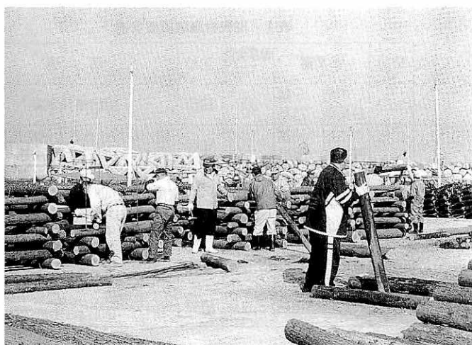
写真④ 間伐材漁礁組み立て風景
