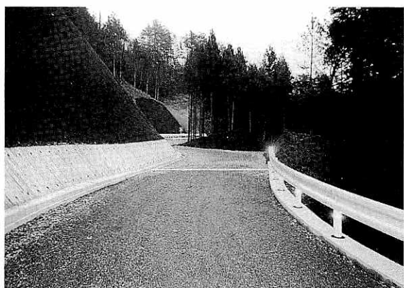
写真③ 間伐材法面保護工
