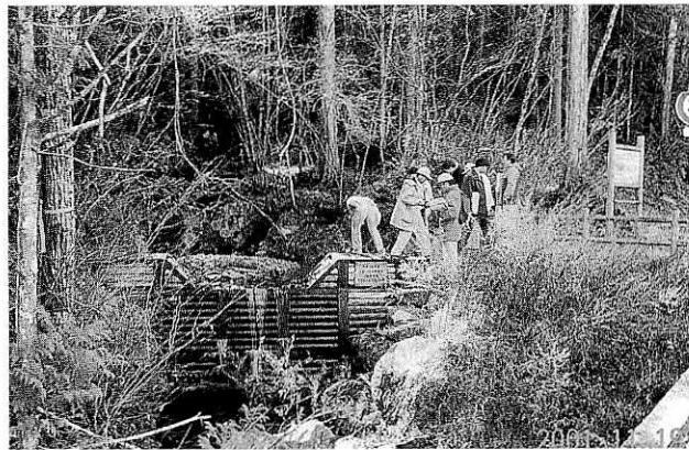
写真④ 木製パネル鋼製柵床固工
