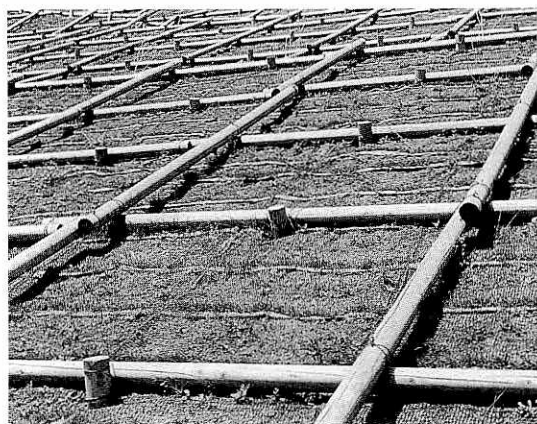
写真⑥ 間伐材法枠工
