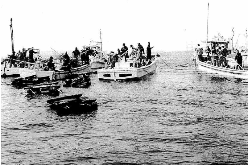
写真⑤ 漁船による沈設作業
