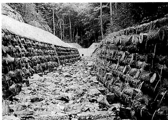
写真⑤ 間伐材流路工
