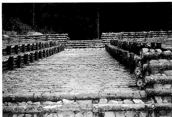
写真④ 間伐材床固工
