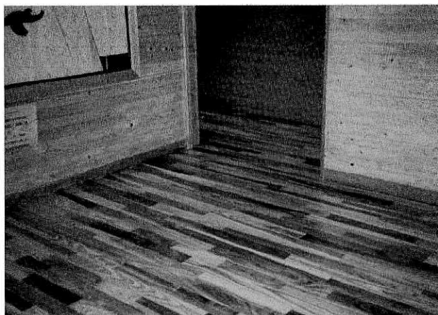
写真③ 表層 WPC 化により車イスにも耐えられるスギ床板の試験施工（富山県木材技術センター）
