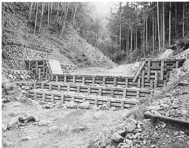
写真② 木製谷止工（高知県 吾川村）
