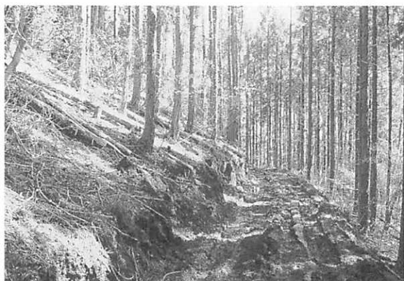
写真① 山側に倒し込んだ作業道支障木
