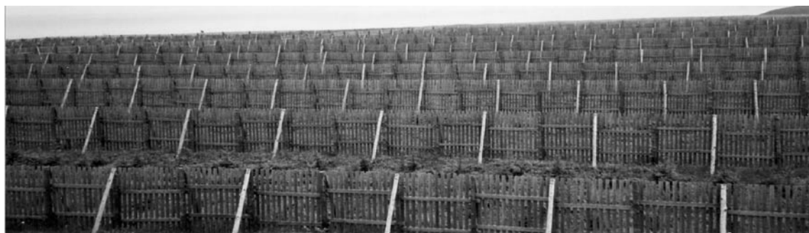
▼写真② 木製防風柵工
