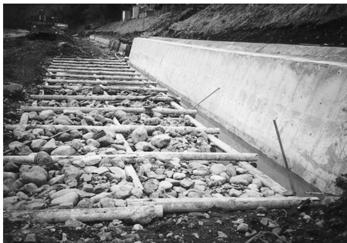
▲写真⑥ 木工沈床
