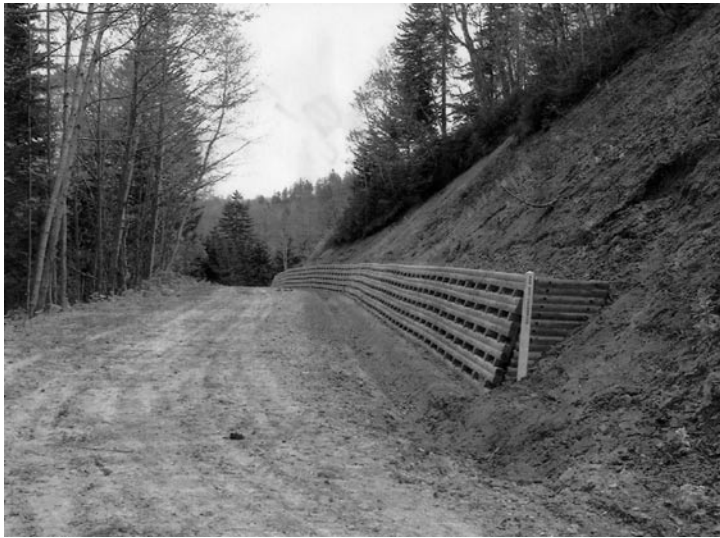
◀写真④ 木製ブロック積工
