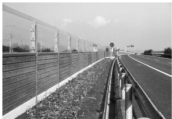
▲写真③ 平成15年度に設置した木製遮音壁（低次加工タイプ）
