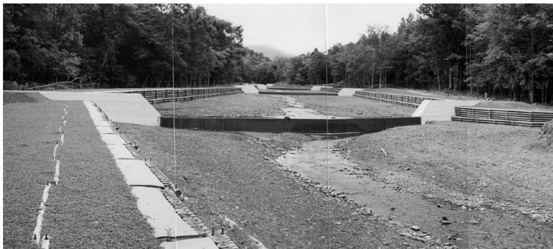
▼写真① 木製護岸工
