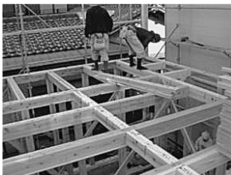
▲写真③ 新軸組構法 (2 階床梁 (スパン 3.64m) とその胴差し等を 4 × 6 寸で統一)
