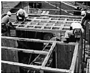
▲写真⑤ 四寸角構法（施工中の2階床）
