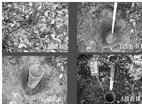
▲写真③ 深い境界点には塩ビ管を設置
