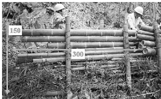
▲写真⑤ 落石防止柵作成状況
