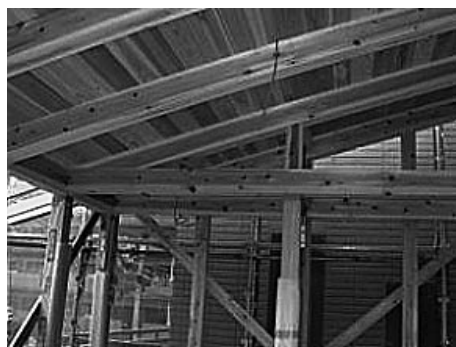
▲写真④ 新軸組構法 (4 × 6 寸ののぼり梁と軒桁材)
