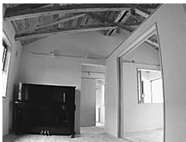
▲写真⑦ 四寸角トラス（竣工後の室内の様子）
