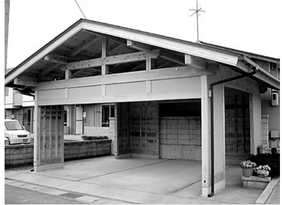
▲写真⑦ 構造にダボが用いられた倉庫
