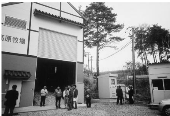
写真⑤ 間伐材チップ・樹皮によるガス化発電施設（ストックヤード。専用の送電線が牧場交流館へひかれている）
