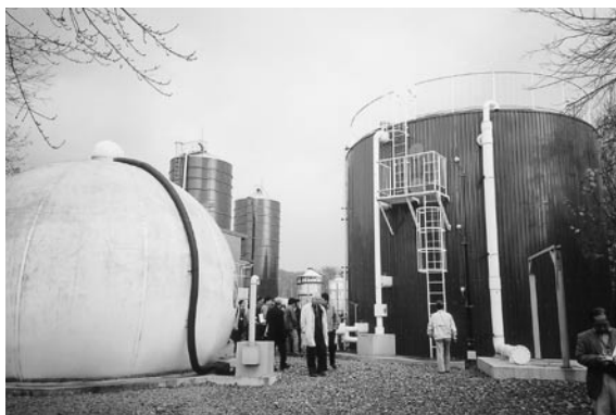
写真⑥ 畜産バイオマスプラント。牛糞尿からメタンガスを取り出し、発電・熱供給のほか消化スラリーを生産する（メタン発酵槽（右）とガスタンク（左））
