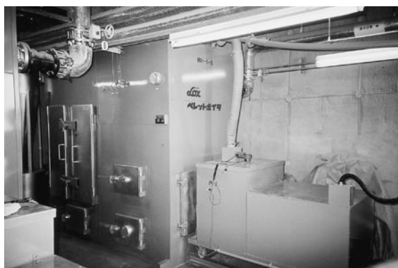
写真④ 介護老人保健施設の木質ペレットボイラー施設（給湯・暖房用。2基）。写真上：ペレットは貯蔵槽の下部パイプから室内ボイラーに送り込まれる。写真中：ボイラー（国産）。写真下：施設内フロアにボイラー温度表示板が掲げている
