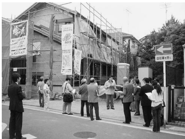
写真① SGEC 認証材を使用した住宅の建築現場（埼玉県ふじみ野市）
