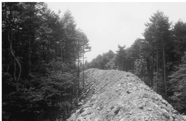
写真③ 道路工事で分断された森
