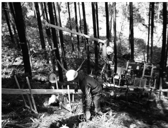
▲写真③ レールの敷設作業
