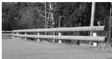
▲写真④ 県道等に設置された信州型木製ガードレール (左から 1, 2, 3 号型)
