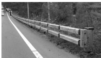
▲写真④ 県道等に設置された信州型木製ガードレール (左から 1, 2, 3 号型)
