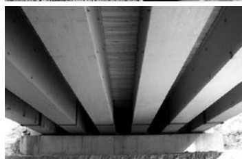
▲写真③ 林道に架設された単純木合成桁橋
