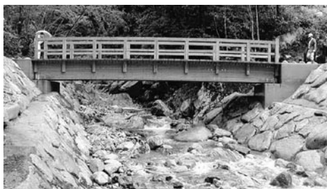
▶写真② 炭素繊維補強集成材使用の木製歩道橋
