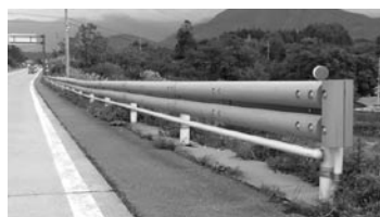
▲写真④ 県道等に設置された信州型木製ガードレール (左から 1, 2, 3 号型)
