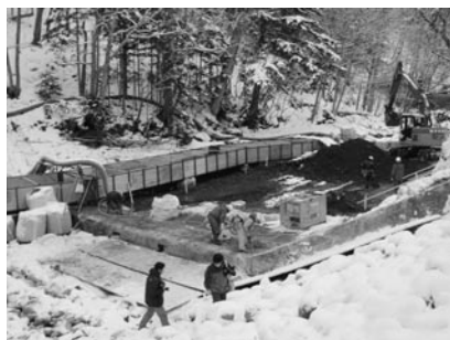
▲写真⑧ サケ科魚類の遡上のために 切り下げられたイワオベツ 川の治山ダム
