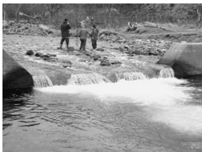
▲写真⑦ サケ科魚類の遡上のために 3箇所の切欠きが入れられ たルシャ川の低ダム
