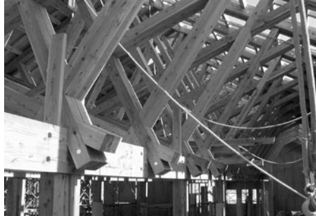
写真② 小屋組部材と 柱材の納まり(工事中)
