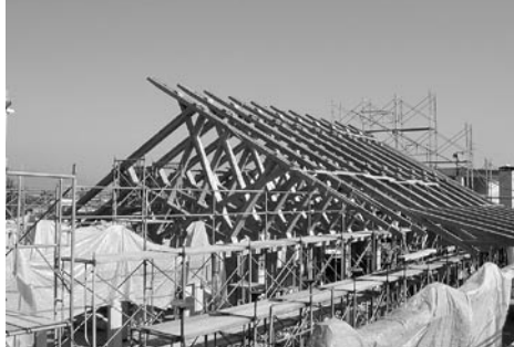
写真① 南棟トラス組 (工事中)
