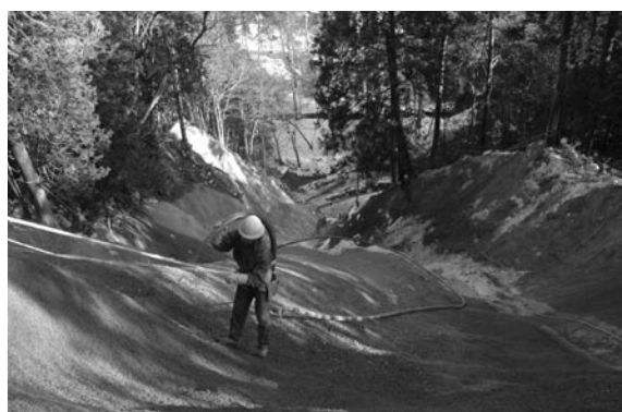
▲写真③ 木材チップ吹き付け作業
