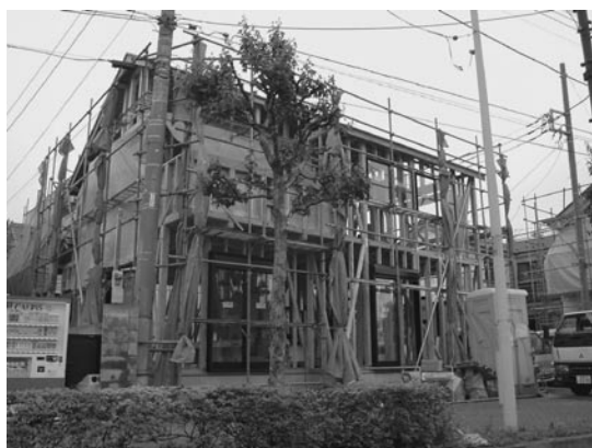
▲カラマツ集成材で建築中の住宅（首都圏では多くの住宅が集成材で建てられている）
