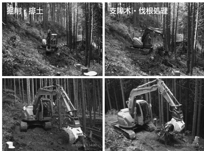
▲写真① グラップルバケットによる作業道作設作業の様子
