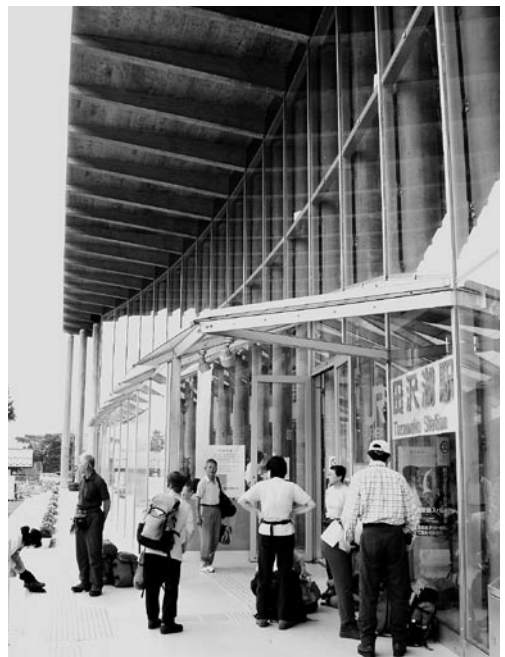
▲JR 田沢湖線田沢湖駅 主要構造部は柱がコンクリート、梁は鉄骨を集成材で被覆、ガラスが多用された斬新なデザインで、内装には「木」がふんだんに使われている。設計は板茂氏。 飯島泰男氏（秋田県立大学）撮影
