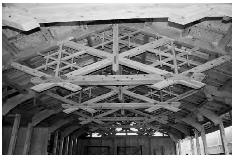
▲小屋組みに和風トラスを構造設計（建築中）
