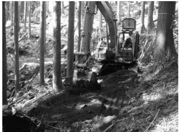
バックホーによる作業路開設（飛騨市森林組合）
