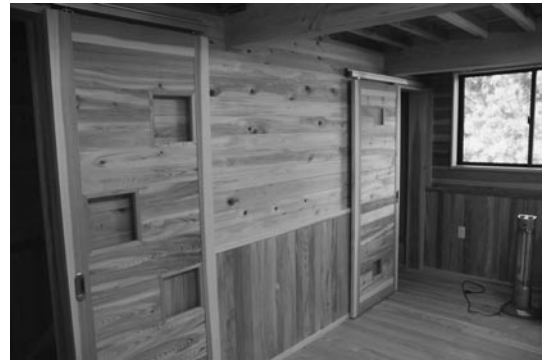
▲写真⑦ 倉庫の内装は、地元のスギ・ヒノキ・マツ・クスノキ・マテバシイ
