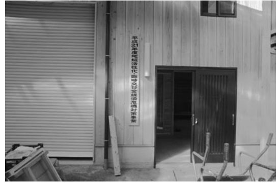
▲写真⑥ 平成22年3月に倉庫を増築（併せて木造の多目的スペースも新築）
