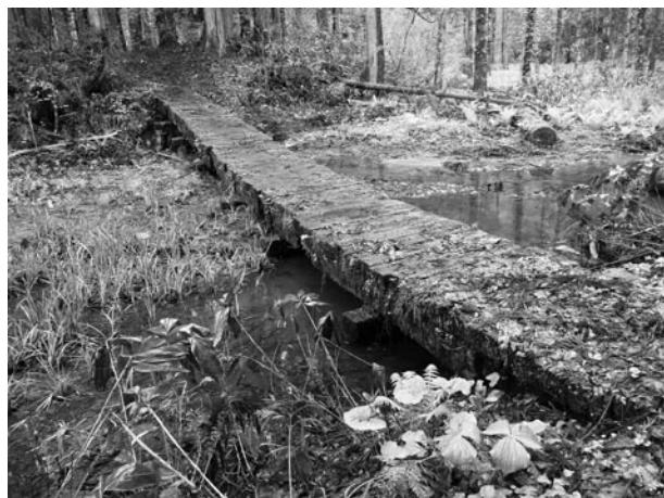
▲写真④ 橋に再利用されているクレオソート油防腐枕木
