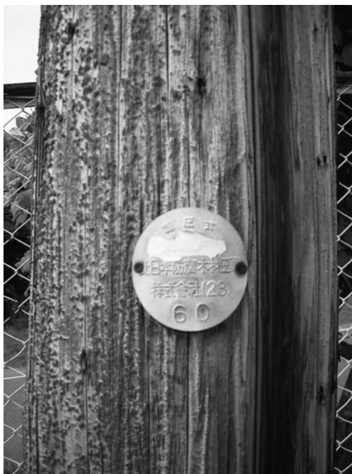
◀写真③ クレオソート油で処理した電柱 銘板から 1960 年に製造されたことがわかる
