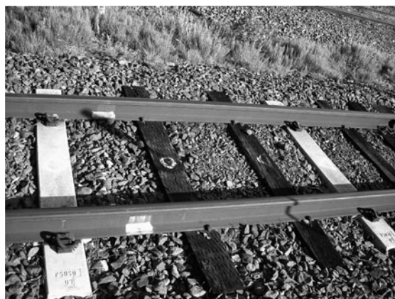
▲写真② クレオソート油で処理した枕木（山田線） 木マクラ木はコンクリート製で置き換え
