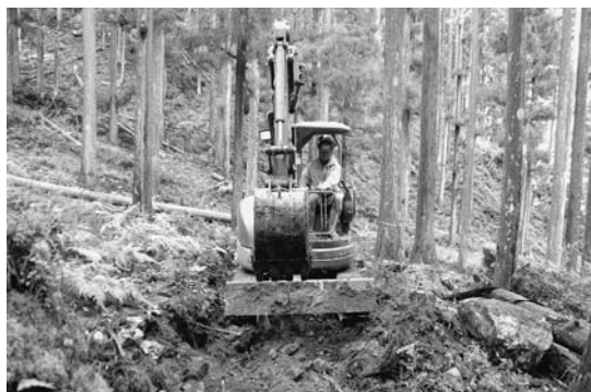
▲写真④ ミニバックホウによる粗道（2.5m）づくり
