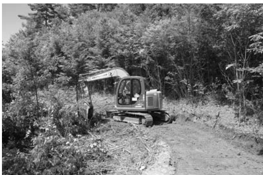
▲写真① 現地研修会場の状況 (切土高が低く、地山傾斜の緩いことが分かる)
