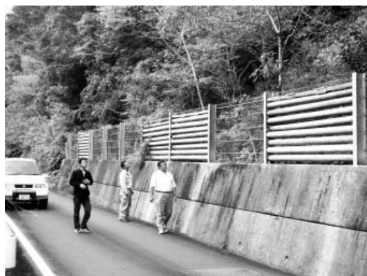
▲写真⑤ 和歌山県が開発した木製落石防護柵の施工事例
