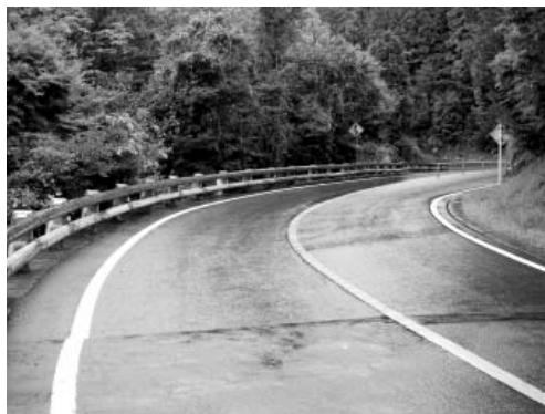
▲写真① 国内で初めて衝突実験に合格した木製車両用防護柵（ウッド Gr）の施工事例
