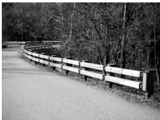
写真② 信州型木製ガードレール 1 号型の施工事例 (写真提供：柴田直明氏／設置数年後の状況)
