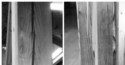
▶写真② 遊学舎柱材の割れ（左）とその補修（右）
