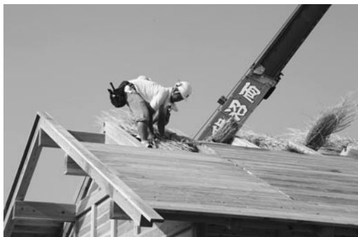
▲写真③ 1寸の化粧野地板の上に四寸角の垂木を配置して1寸の荒野地板を貼り、その間に断熱材として茅を入れる
