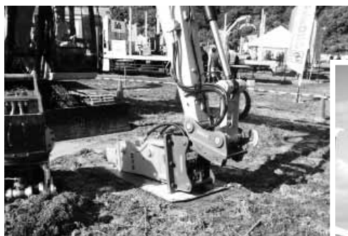
▲写真⑩ オイルクイック (オペレーターが機械に乗ったまま、 アタッチメントの交換が可能)
