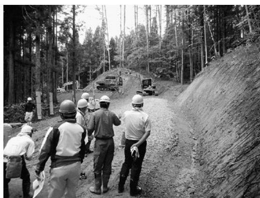
▲写真② 屋根型構造の作業道の状況
