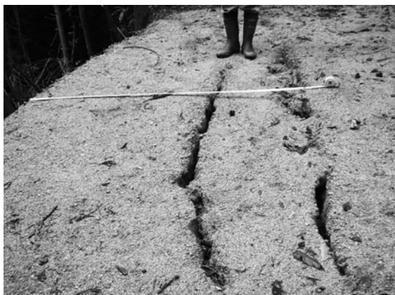
▲写真② 路体盛土に生じた亀裂
