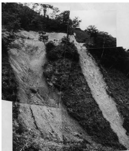
▲写真① 作業道の路肩崩壊
