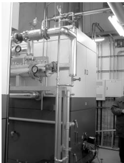
▲写真② 温水プールへのチップボイラーの導入例（岩手県ではこうした公的施設への導入が先導してきた。）
