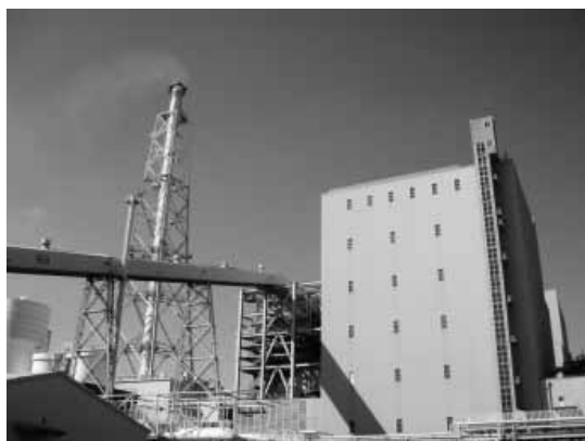
▲写真⑥ 中国電力(株)新小野田発電所 (発電出力:100 万 kW = 50 万 kW×2 基)
