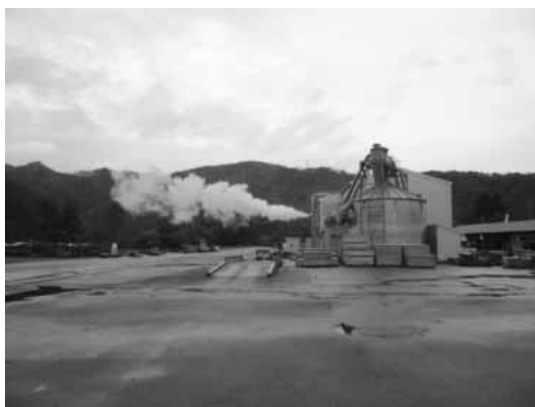
▲写真⑦ 間伐材等を原料とする県森連の 木質ペレット製造施設
