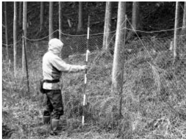
▲写真 A 金網フェンス
