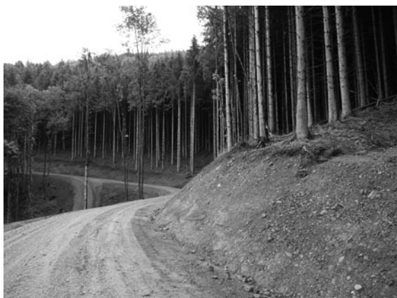
▲写真④ 山側の素掘り側溝
