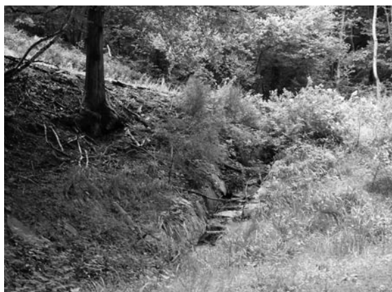
▲写真⑤ 斜面下の水処理
