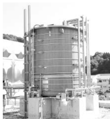
◀写真② 木製の受水槽
