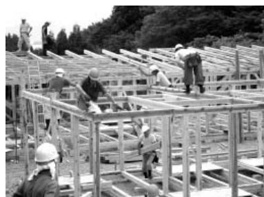
▲木造仮設住宅建設の様子
