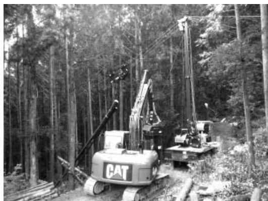
▲写真④ タワーヤーダとプロセッサ
