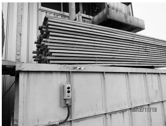
▲写真④ 防腐処理
