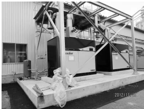
▲写真⑥ 発電機
