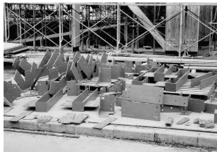
▲写真④ 集成材用接合金物
