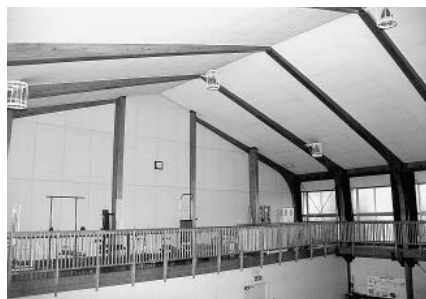
▲写真③ 森林総合研究所の工作室・倉庫（1978 年竣工、つくば）
