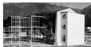
▲写真⑥ バルコニーが上階延焼を抑制する様子(第二回実験：再点火後90分)
