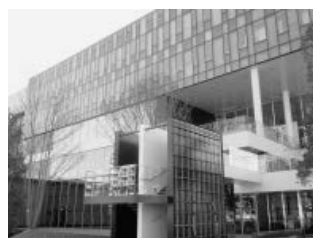
▲写真③ 木造6階建て庁舎建築
