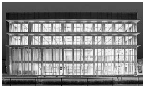
写真② プラテック本社ビル
