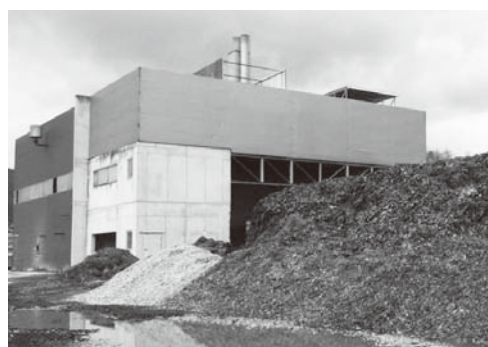
▲写真② コフラック市の製材工場敷地内に建設されたCHPプラント
