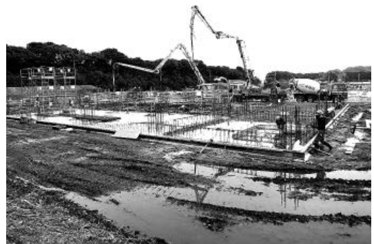
▲写真① 日南工場で建設が始まった 木質バイオマス発電施設
