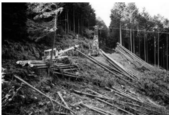
▲写真② タワーヤード集材
