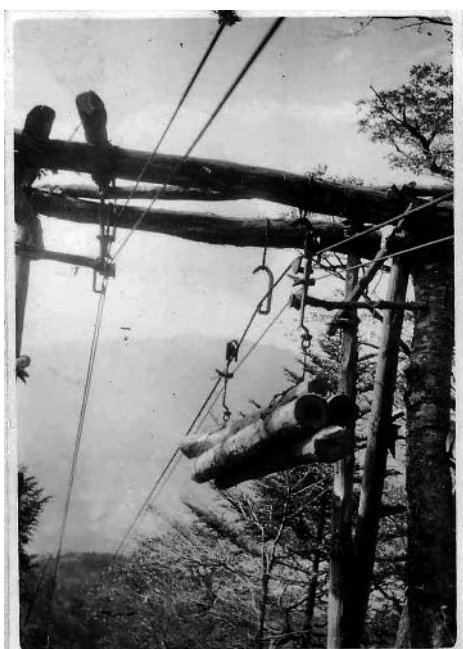
▲写真② 運材索道による集材風景 (中津川市の森林所有者から提供)
