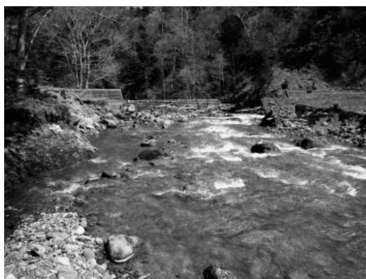
▲写真④ スリット化後に堆積土砂の大半が自然流下した（イワウベツ川：北海道森林管理局施工箇所）
