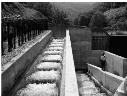
▲写真③ 台形断面魚道を設置 (チエンベツ川：北海道施工)
