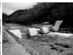
▲写真①（左） 全面切り下げした治山ダム
