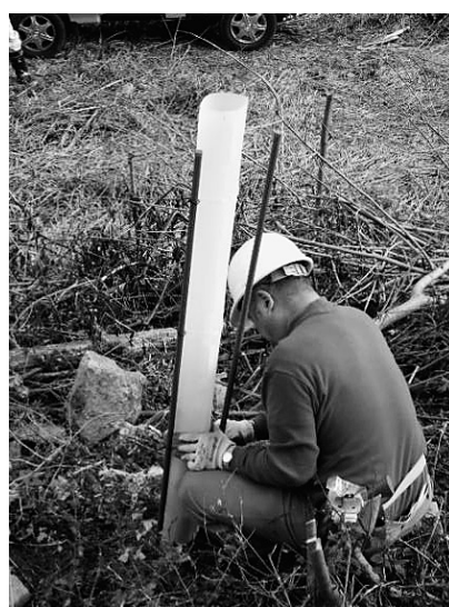
▲写真② ツリーシェルターの設置
