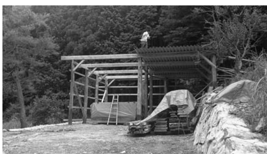
▲写真③ 製材品と建築中の木材保管庫
