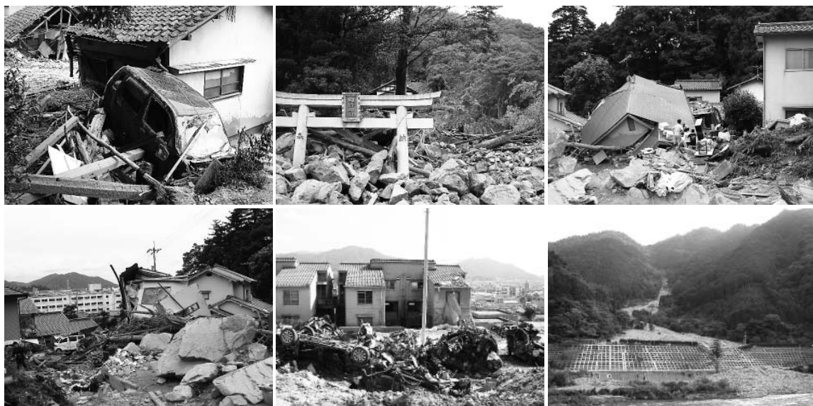
▲写真① 最近の土砂災害事例（2014 年 8 月 20 日発生，広島市）
