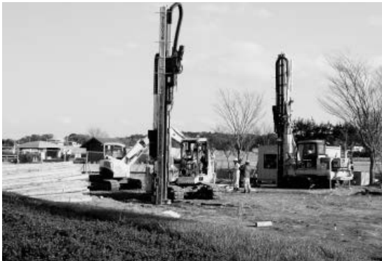
▲写真① 丸太の打設状況
