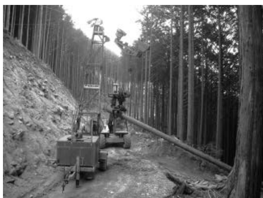
▲写真① 作業風景
