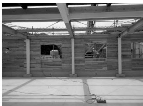
▲写真⑥ 壁パネルとしての利用
