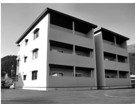
▲写真⑦ 今年3月に竣工した3階建て共同住宅
