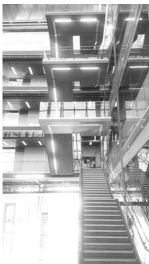
▲写真⑥ CLTの「空飛ぶ階段」
