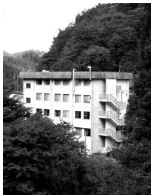
▲写真① 稲武フィールド庁舎
