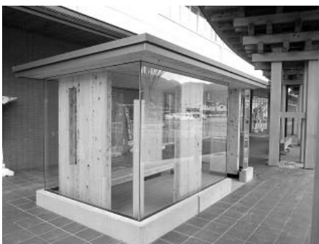
▲写真④ バス停躯体としての利用
